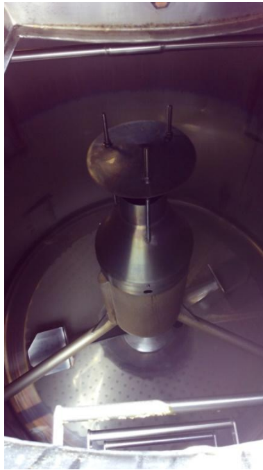
Imatge 16. Interior d'una caldera Moritz.
