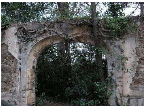
Fig. 12: Estat actual de la façana del casino de l'Arrabassada.
