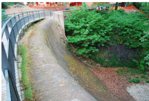
Fig. 168: Presa del pantà
